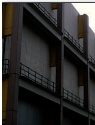
Die Tierversuchsanstalt der Uni Düsseldorf (Gebäude 22.22) - man erfährt fast nichts darüber auf der Uni-Homepage. Die Fenster sind abgehangt. Foto: privat
